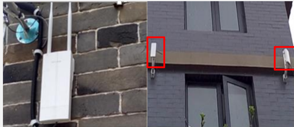
借助建筑物外墙壁挂/抱杆安装
