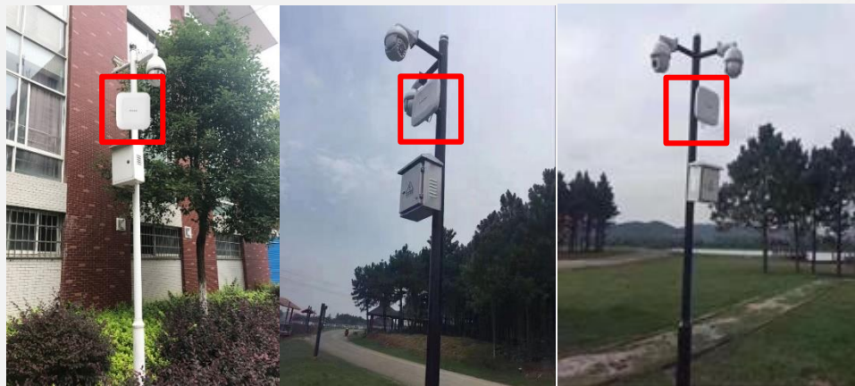
借助监控杆抱杆安装
