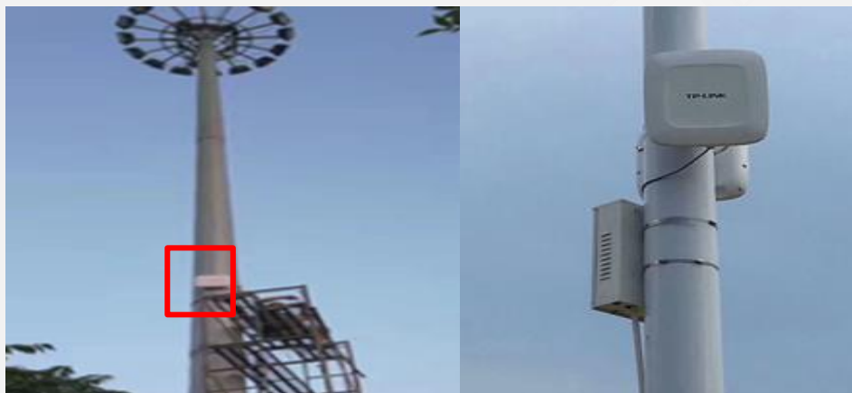
借助户外照明灯和固定支架安装
